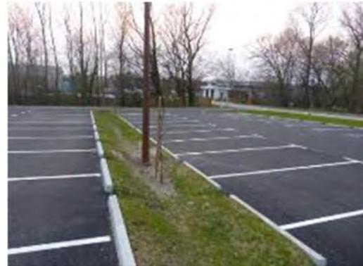
*Infiltration des eaux pluviales dans une noue (gestion des
