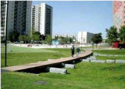
*Infiltration des eaux pluviales dans un parc inondable
