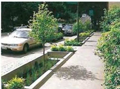
*Infiltration des eaux pluviales dans des massifs végétaux
