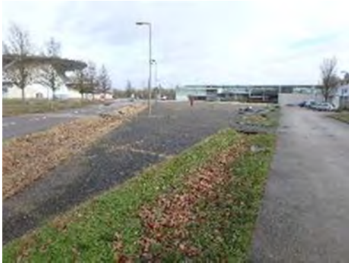
Infiltration des eaux pluviales de l'esplanade du Centre Nautique à Chalon-sur-Saône, dans des noues (gestion des pluies courantes et moyennes à fortes)
