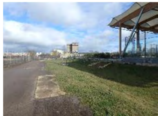
Infiltration des eaux pluviales du parc Eugène Freyssinet à Saint-Rémy, dans une noue (gestion des pluies moyennes à fortes)
