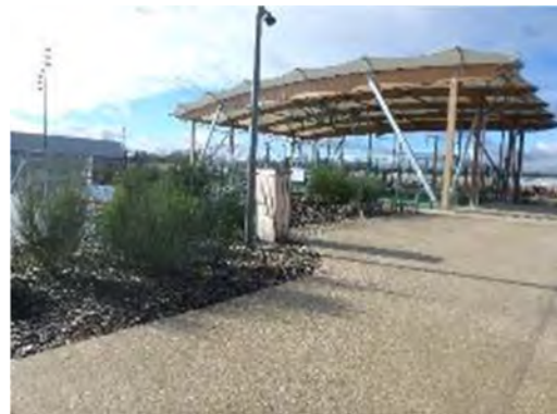
Infiltration des eaux pluviales du parvis du parc Eugène Freyssinet à Saint-Rémy, dans les massifs végétaux (gestion des pluies courantes + moyennes à fortes)
