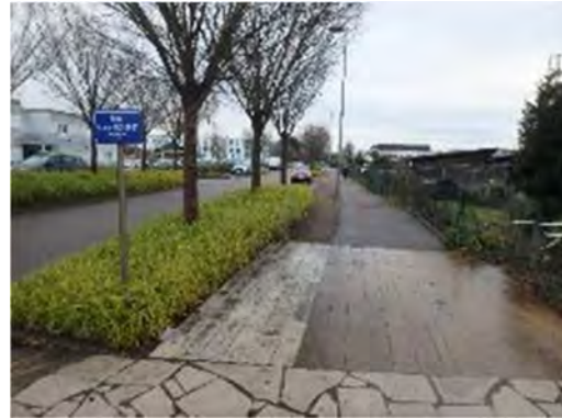
Infiltration des eaux pluviales du trottoir dans un massif végétal, allée Francis Lechenet à Chalon-sur-Saône (gestion des pluies courantes + moyennes à fortes)
