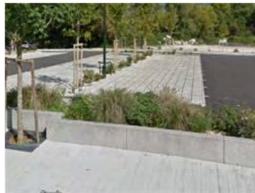
Infiltration des eaux pluviales à travers des stationnements poreux (gestion des pluies courantes + moyennes à fortes)
