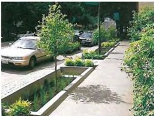
Infiltration des eaux pluviales dans des massifs végétaux (gestion des pluies courantes + moyennes à fortes) (source : Cobamil)
