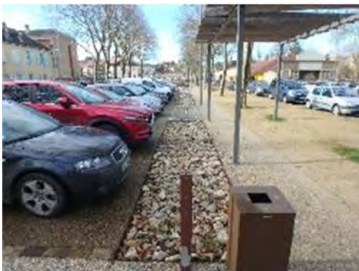
Infiltration des eaux pluviales des stationnements de la Maison des Vins à Chalon-sur-Saône, dans une tranchée d'infiltration (gestion des pluies courantes + moyennes à fortes)
