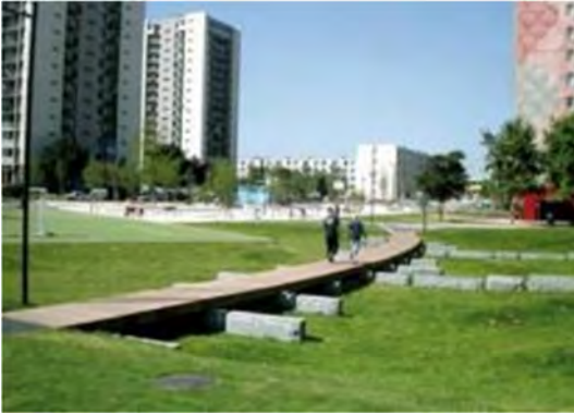
Infiltration des eaux pluviales dans un parc inondable (gestion des pluies courantes + moyennes à fortes)
