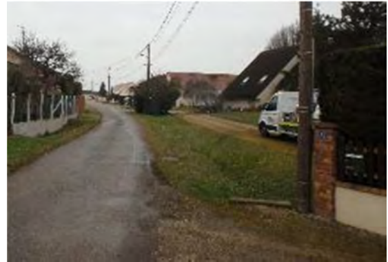
Infiltration des eaux pluviales de la chaussée dans une noue à Sassenay (gestion des pluies courantes et moyennes à fortes)
