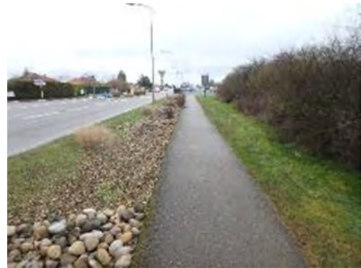
Infiltration des eaux pluviales de la chaussée et de la piste cyclable dans une tranchée, route d'Autun à Chatenoy-le-Royal (gestion des pluies courantes et moyennes à fortes)
