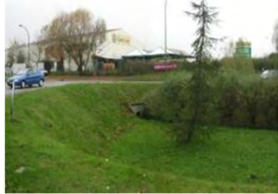
Infiltration des eaux pluviales à l'intérieur d'un rond-point
