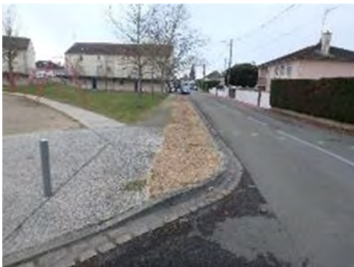
Infiltration des eaux pluviales du trottoir dans une noue, rue Edgar Degas à Chalon-sur-Saône (gestion des pluies courantes + moyennes à fortes)
