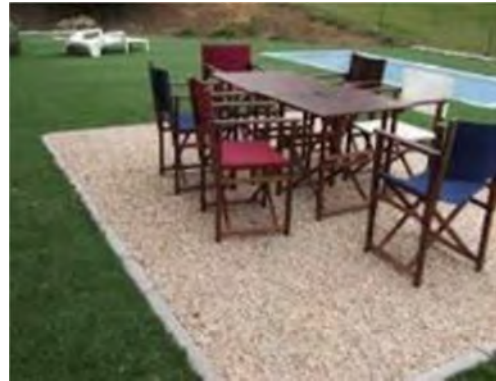
Infiltration des eaux pluviales à travers une terrasse en graviers (gestion des pluies courantes + moyennes à fortes) (source : Serge Bollard Paysagiste)
