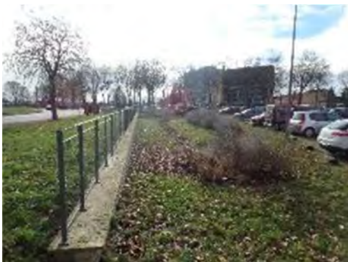
Infiltration des eaux pluviales de la Maison des Vins à Chalon-sur-Saône, dans un espace paysager (gestion des pluies courantes et moyennes à fortes)
